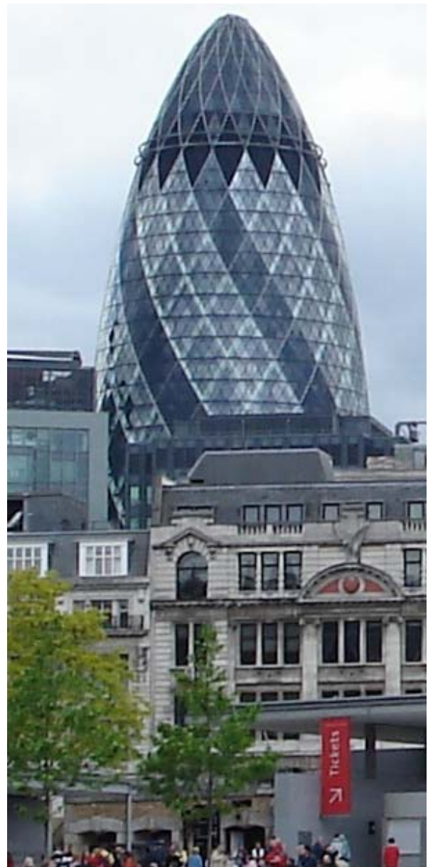
ロンドンにある環境に配慮したスイス再保険会社のビル
